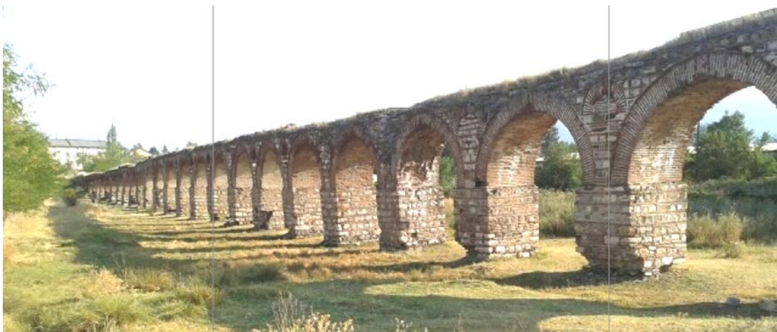
Слика 4: Навалени столбови (с а. 19-27) во јужниот дел на Аквадуктот, под влијание на таложењето на почвата
