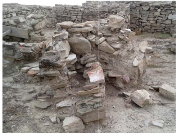
Слика 14: Превртување и паѓање на изложени сидови по ерозија на малтерот и честичките
