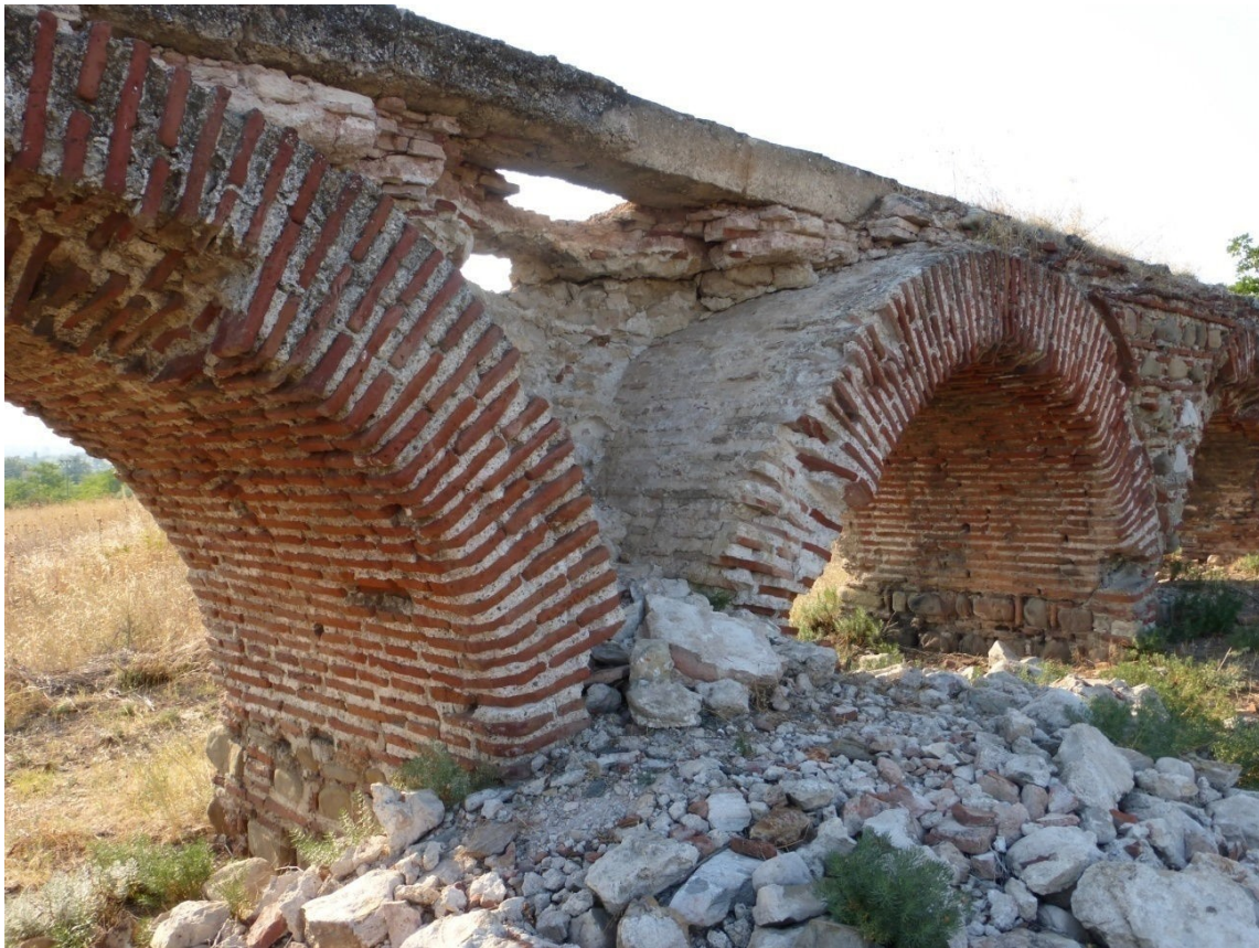
Слика 9: Оштетување на циглите на врвот на Аквадуктот и помеѓу сводовите, предизвикано од мрзнење
