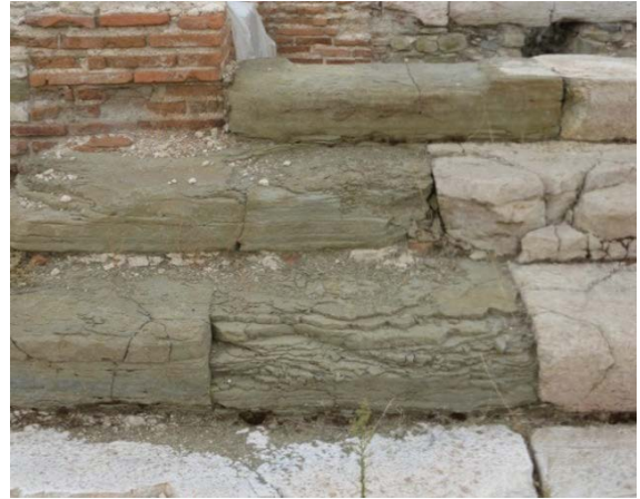
Слика 12: Оштетување на различни от како резултат на мрзнење камени материјали
