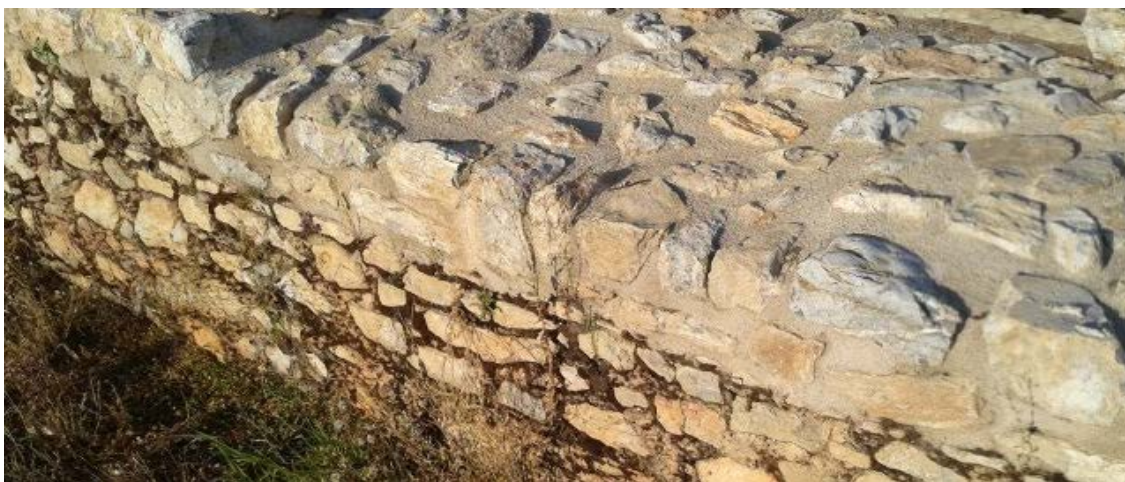
Слика 22: Дополнителни горни слоеви додадени за заштита на ископаните историски сидови
