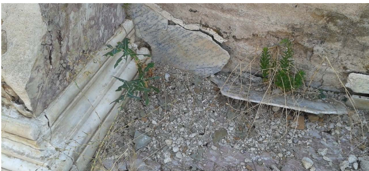
Слика 19: Одделување на површинските слоеви како резултат на мрзнење и вегетација
