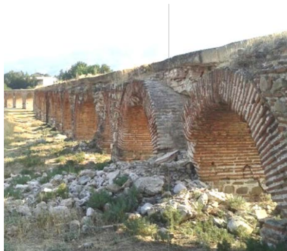
Слика 6: Оштетувања предизвикани од навлегување на дождовница
