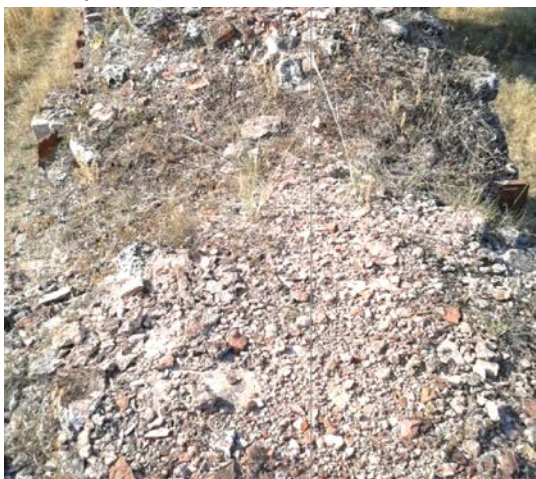
Слика 5: Горната површина на Аквадуктот со оштетувања предизвикани од ерозија од ветер и вода
