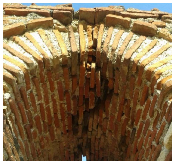
Слика 3: Оштетувања во структурата предизвикани од промена во темелите
